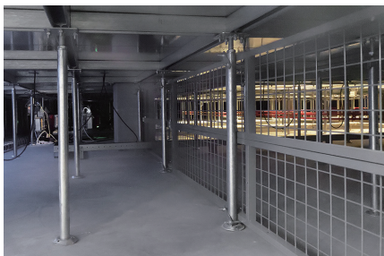
建筑地板与机房架空地板之间的网格面板示例
